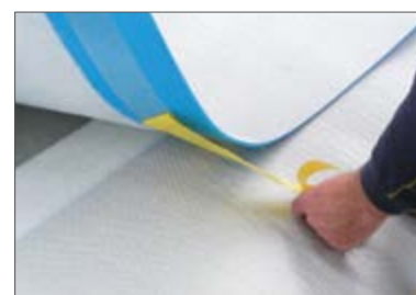
(2) Enlever la bande protectrice du recouvrement autocollant
