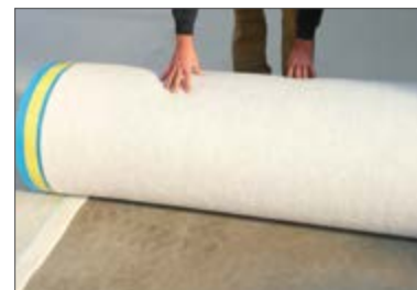
(1) Respecter un recouvrement sur le rouleau adjacent
