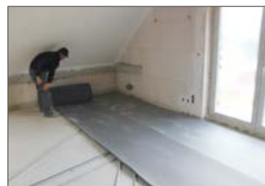
Entrollen Sie die insulit Bi+20 Bahnen Kante an Kante
