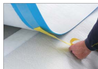
(2) Die Schutzschicht des Klebbandes abziehen
