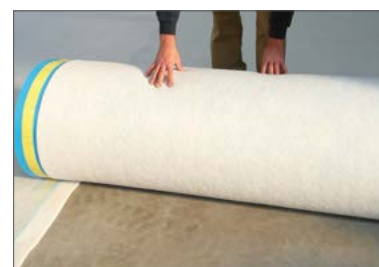
(1) Überlappende Verlegung vom insulit Bi+9 BS
