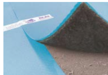
(1) Dérouler l'insulit 4+2 avec un recouvrement de 5 à 10 cm
